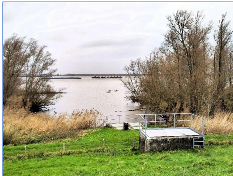
Figuur 13-1 Zicht op het Hollands Diep ter hoogte van gemaal Schuddebeurs
