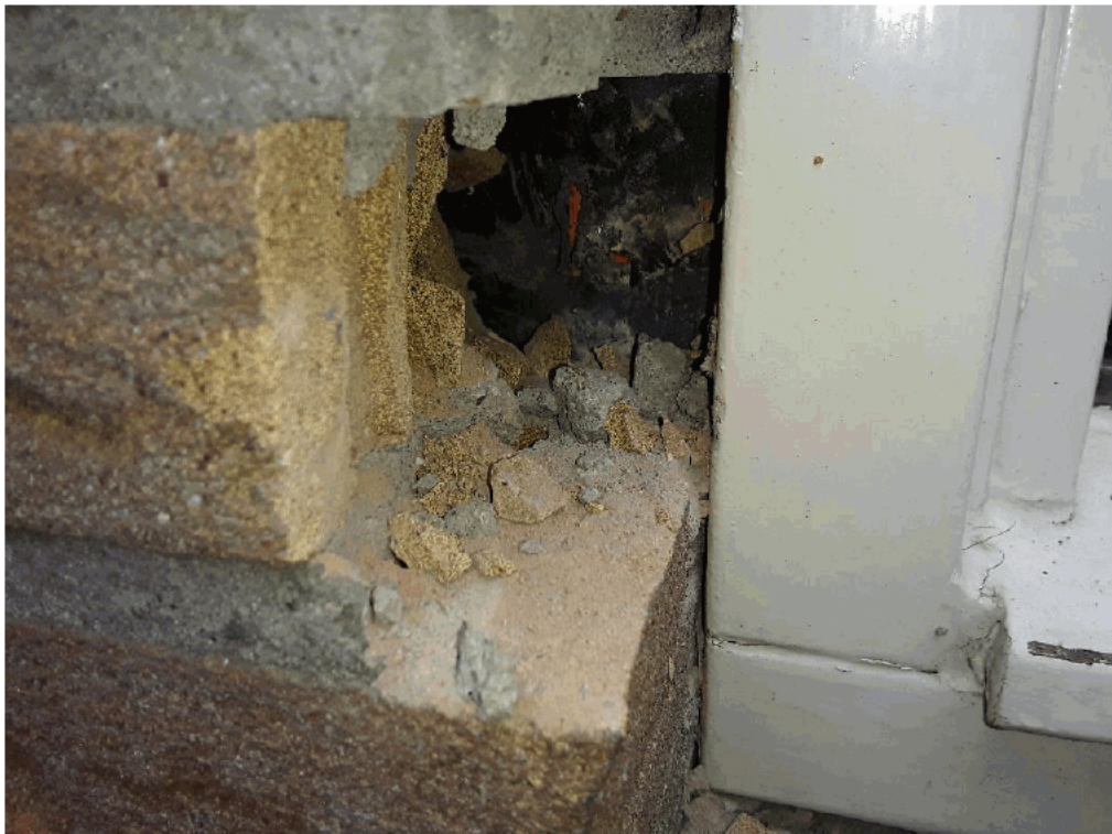
groene allee in spouw geen asbestverdacht materiaal aangetroffen
