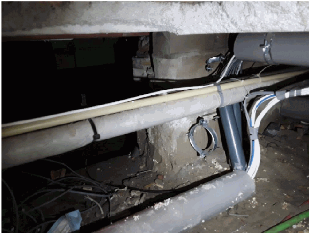
Riolering van PVC.
