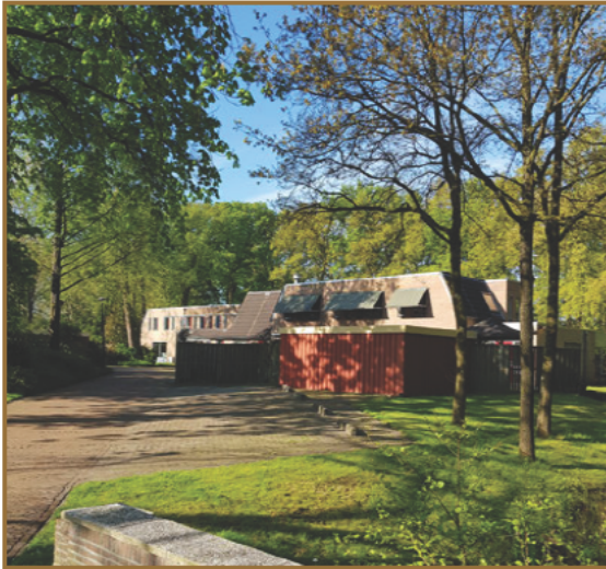
Afbeelding 2.14: Overzichtsfoto van een gebouw in deelgebied C.
