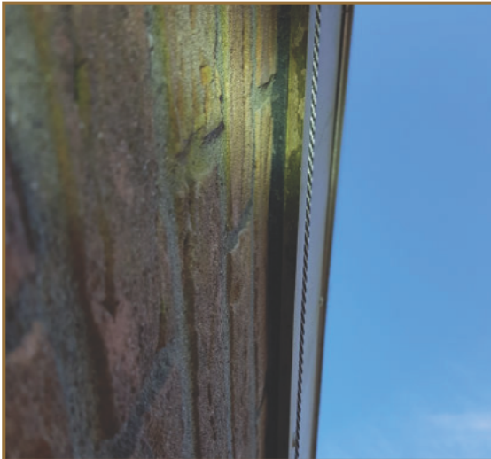
Afbeelding 2.22: De daklijst van het gebouw in deelgebied D sluit strak aan op de muur.
