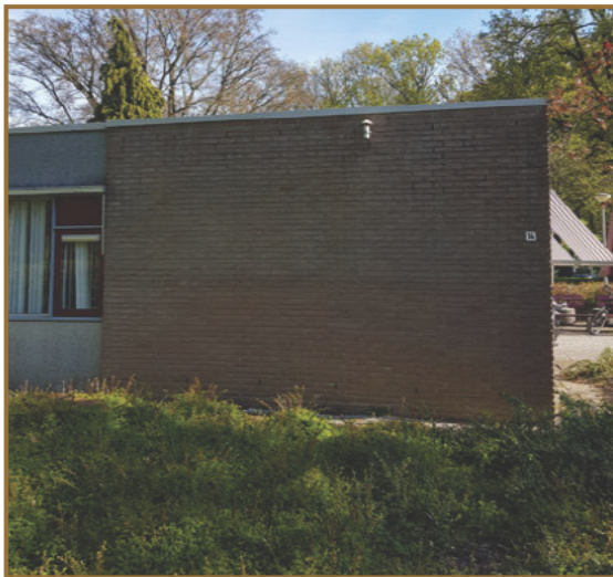
Afbeelding 2.4: Een aantal open stootvoegen in deelgebied A.
