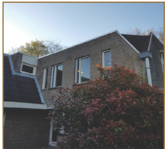
Afbeelding 2.25: Open stootvoegen in de bebouwing van deelgebied D.
