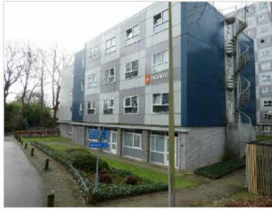
Figuur 1.2 Oostzijde van de onderzoekslocatie.
