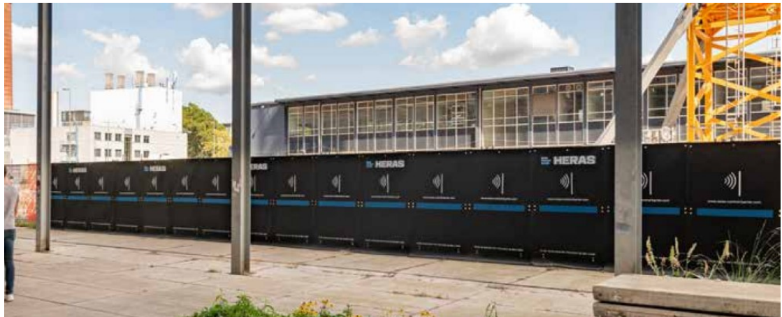
Figuur 8. Beeld van het geluidswerend scherm van Heras Noise control Barrier 2.0 die geluiden van de aanlegactiviteiten van baan 4 met maximaal 32,8 dB zullen verminderen.
