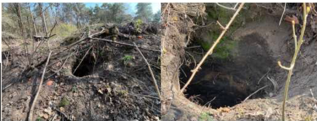
Noordelijke bestaande pijp
