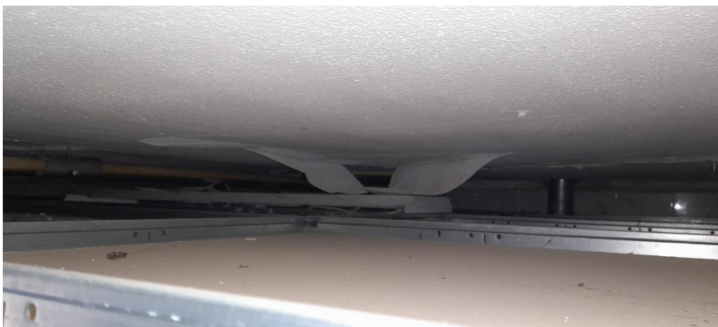
Afbeelding 3: De ruimte tussen de dakplaten en het plafond gebouw 1
