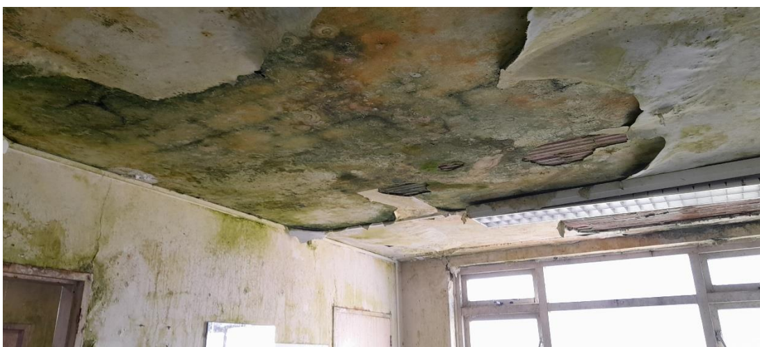
Afbeelding 16: De binnenkant van gebouw 6
