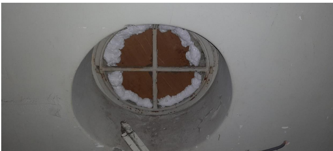
Afbeelding 6: Een van de recent afgesloten ramen, gebouw 2
