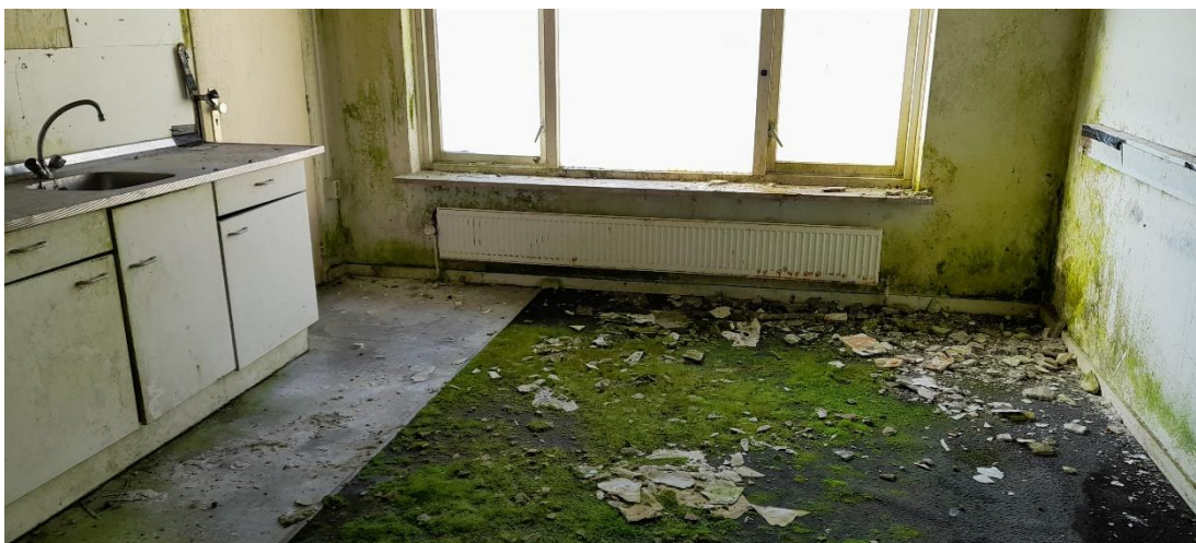
Afbeelding 15: De binnenkant van gebouw 6
