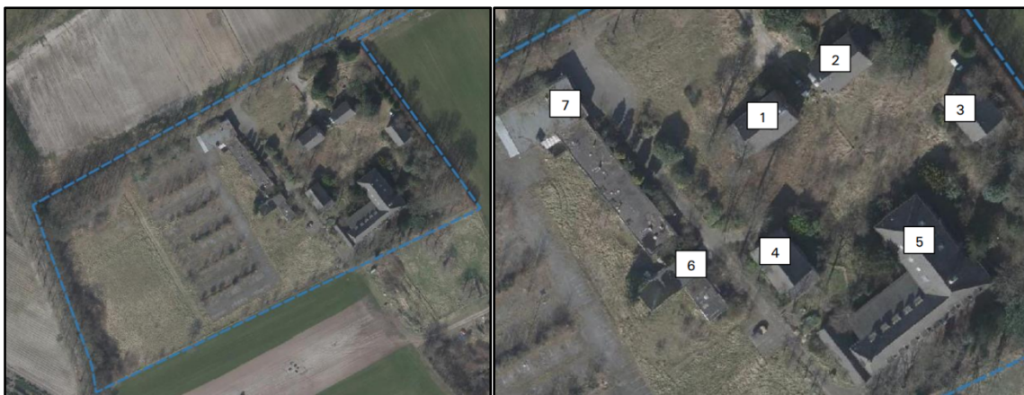
Figuur 1. Locatie Ettensweg 97 te Rijsbergen met de bebouwing genummerd. De activiteiten vinden Plaats binnen het omliggende gebied. Bijgebouwtjes van gebouwen 1, 2, 3, 4 en 5 worden gesloopt en gebouw 6 en 7 worden geheel gesloopt. De hoofdgebouwen van gebouw 4, 5 en 6 worden volledig gerenoveerd. Van de hoofdgebouwen van gebouw 1 en 2 worden enkel de muren gestript van kozijnen.
