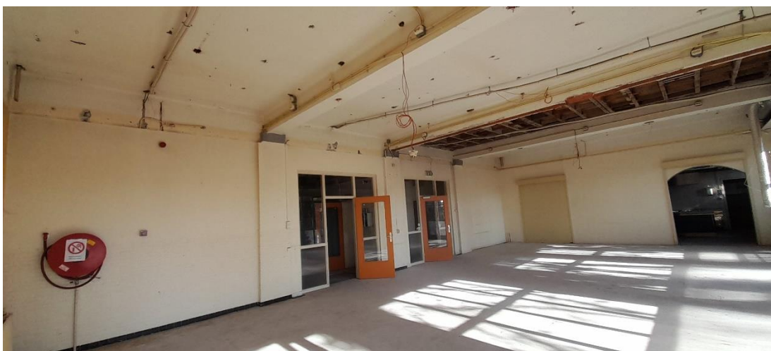
Afbeelding 11: De binnenkant van gebouw 5.
