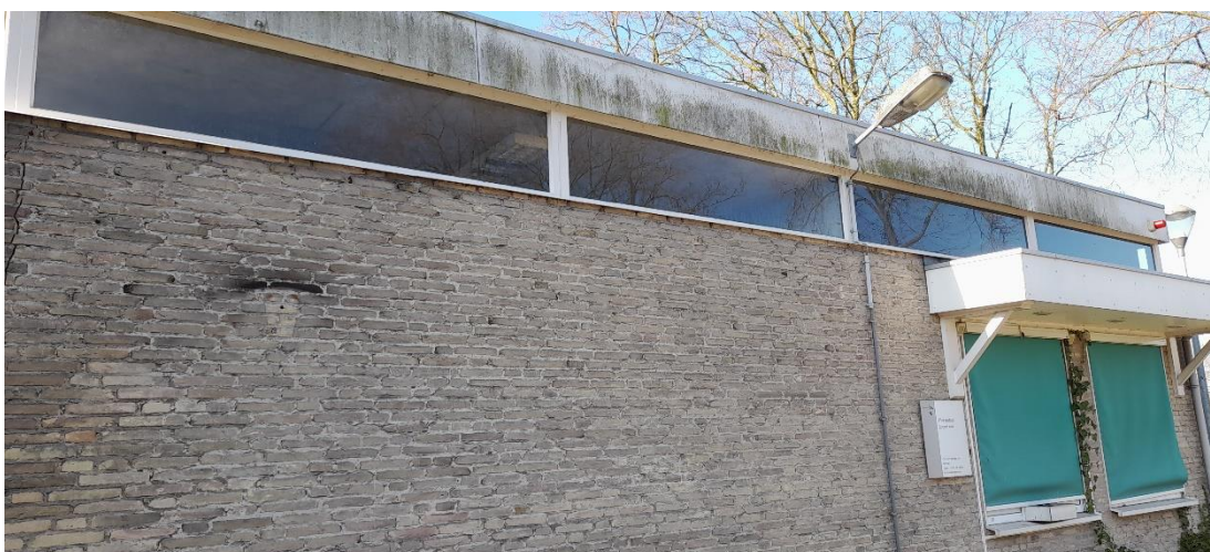
Afbeelding 18: De voorkant van gebouw 7
