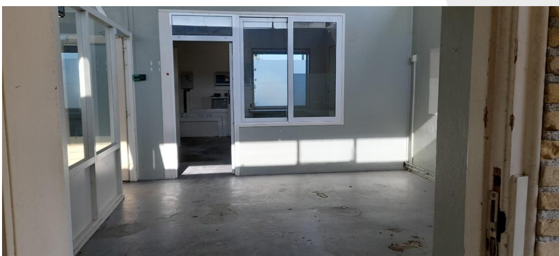
Afbeelding 20: De binnenkant van gebouw 7
