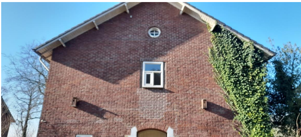
Afbeelding 1: De voorkant van gebouw 1
