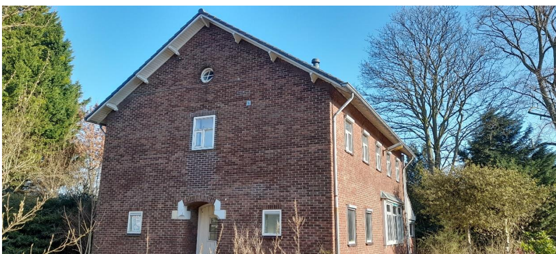
Afbeelding 9: De voorkant van gebouw 4
