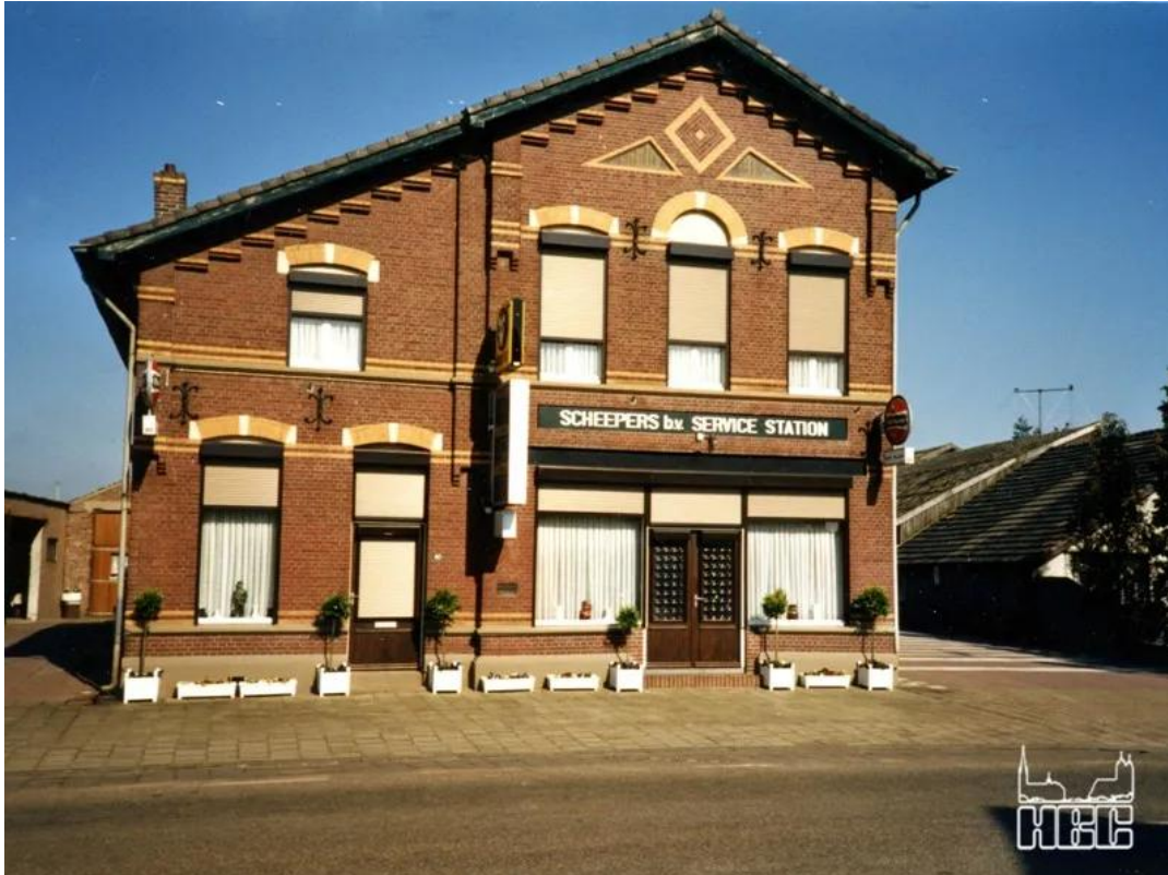
Gemeentelijk monument café-woonhuis 'De Statie' Stationsstraat 80 in Maarheeze (bron Heemkundekring "De Baronie van Cranendonck").
