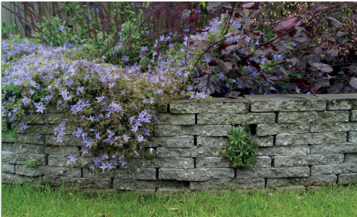
STAPELMUUR VAN HERGEBRUIKTE BETONTEGELS
