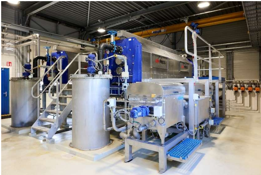
Figuur 23 Schroefpersen AWZI Tollebeek
