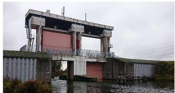
Figuur 6 De Lage Knarsluis tijdens een proefsluiting
