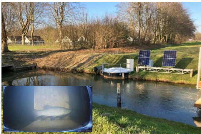
Figuur 17: Vispassage bij stuw in de Spijktocht, met linksonder één van de gebruikers, een zeelt.
