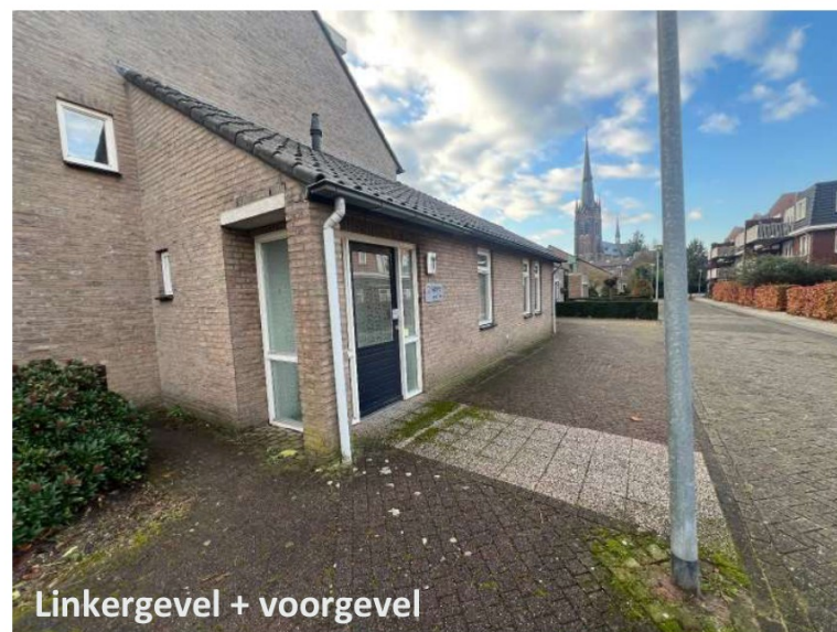
Voorgevel Kloosterhof 1A
