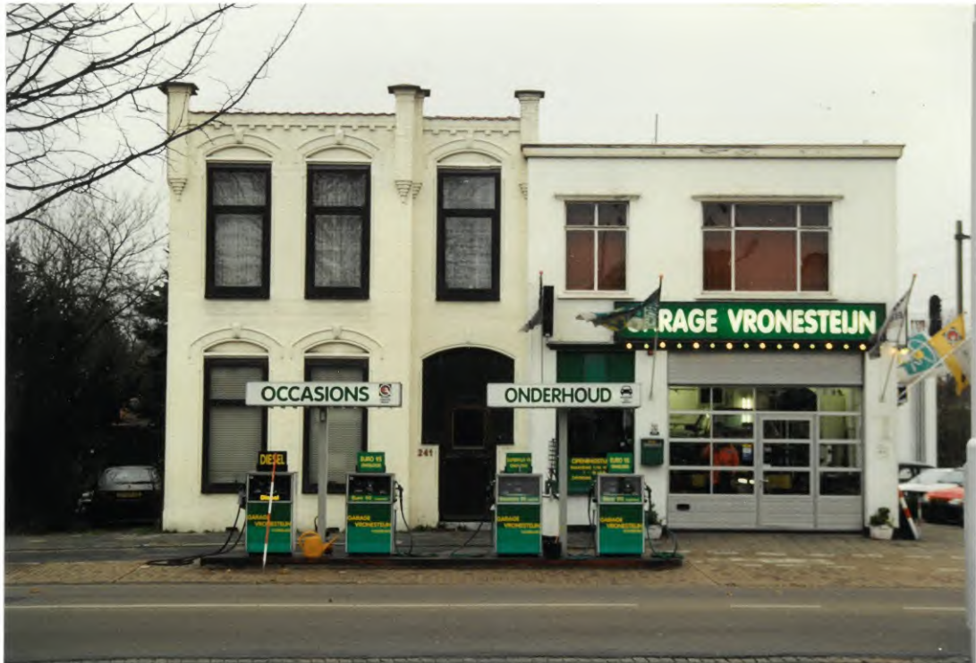
Foto 7. Situatie pompstation 'Vronesteijn', Oosteinde 241-243.
