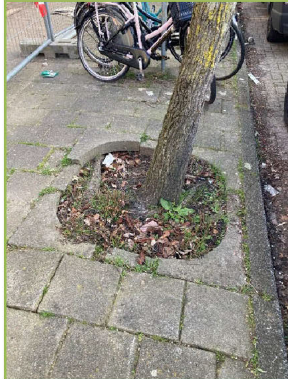
Figuur 10: Opdruk van het trottoir bij boom 66 Kolibristraat.
