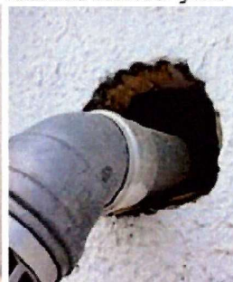
ventilatie doorvoer gevel
