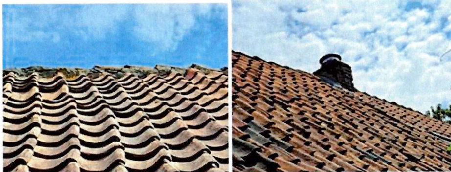
Dak aanzicht voorgevel
