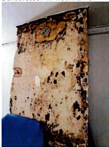
Schoorsteen in woonkamer
