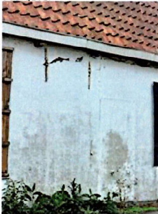
Diverse scheuren en afgebrokkelde pleisterlagen bijgebouw
