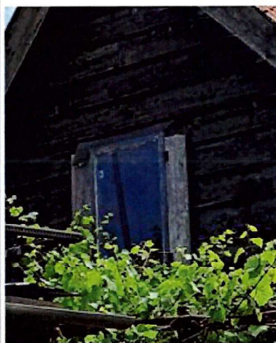
Gevelopening in de rechtergevel
