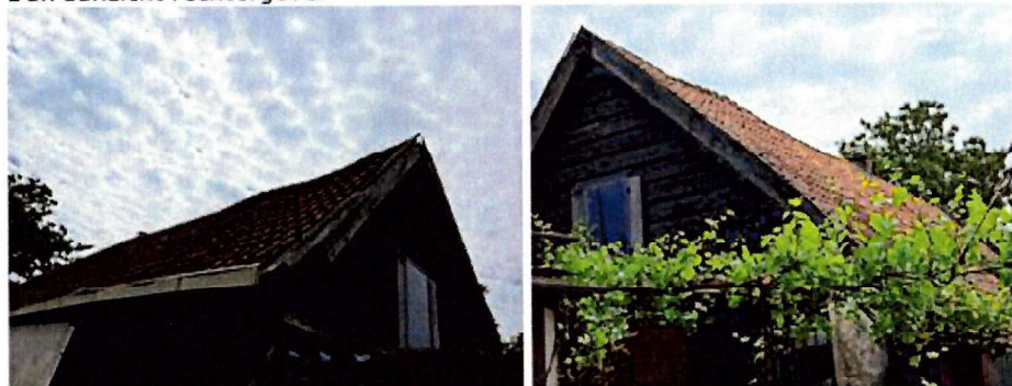
Dak aanzicht rechtergevel
