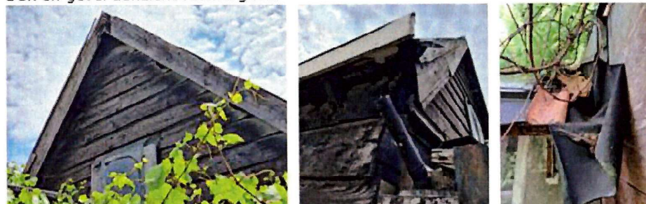
Dak en gevel aanzicht rechtergevel
