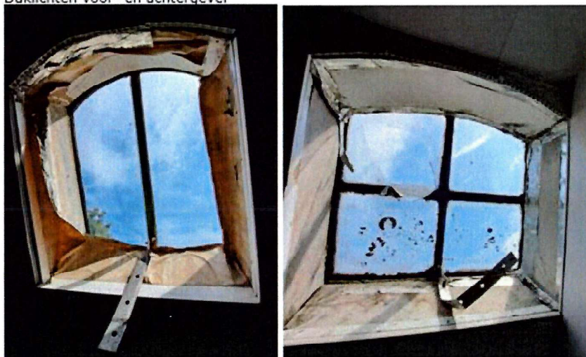
Daklichten voor- en achtergevel
