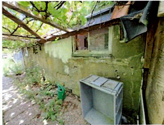
Bijgebouw en frame overkapping
