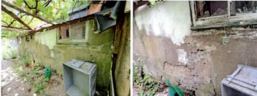
Diverse scheuren en afgebrokkelde pleisterlagen bijgebouw
