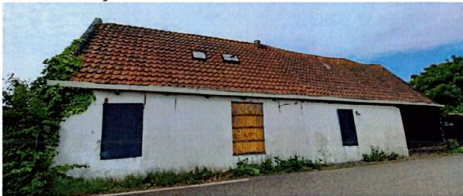
Dak aanzicht voorgevel
