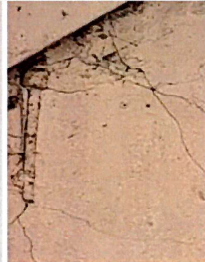
Gevelanker muur keuken
