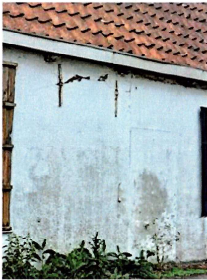
Gevelankers in de voorgevel
