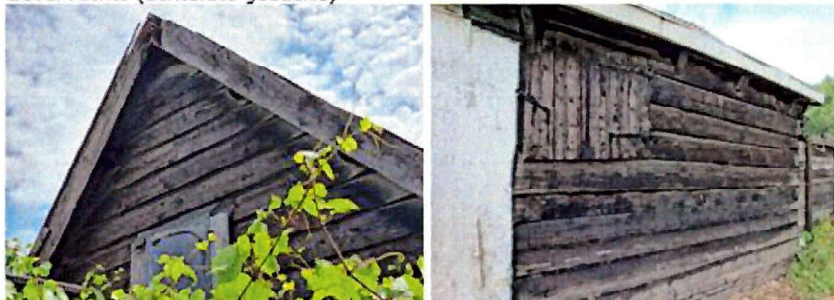
Gevel rechts (achterste gedeelte)
