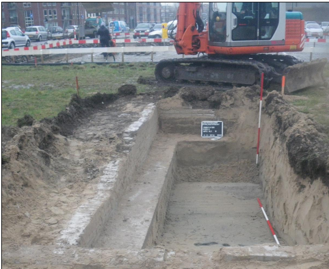
Figuur 11: WP3 werd aangelegd tussen de betonnen funderingen van de voormalige flat.
