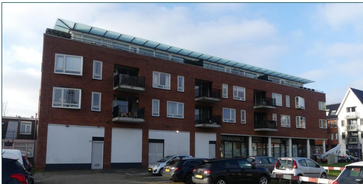
Figuur 2 Het appartementencomplex grenzend aan de planlocatie bevat veel open stootvoegen die vleermuizen toegang bieden tot de spouwruimte.
