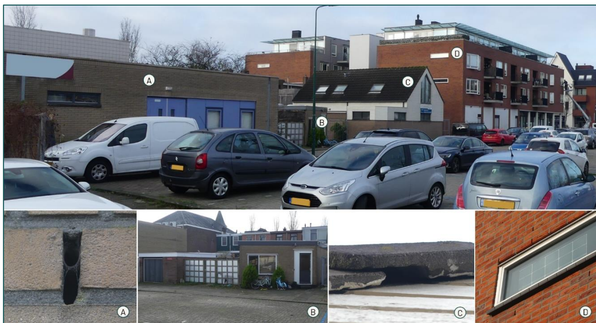
Figuur 3.1 De planlocatie grenst aan bebouwing (boven). Detailfoto's (onder) corresponderen met de overzichtsfoto en geven openingen weer die vleermuizen toegang kunnen verlenen tot een open dakruimte en/of spouwmuur, met uitzondering van 'B'.
