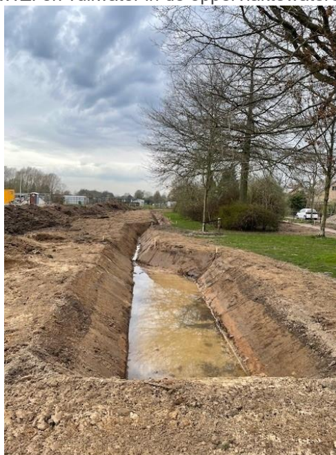
Figuur 7-1 Het graven van extra waterberging in Woudenberg
