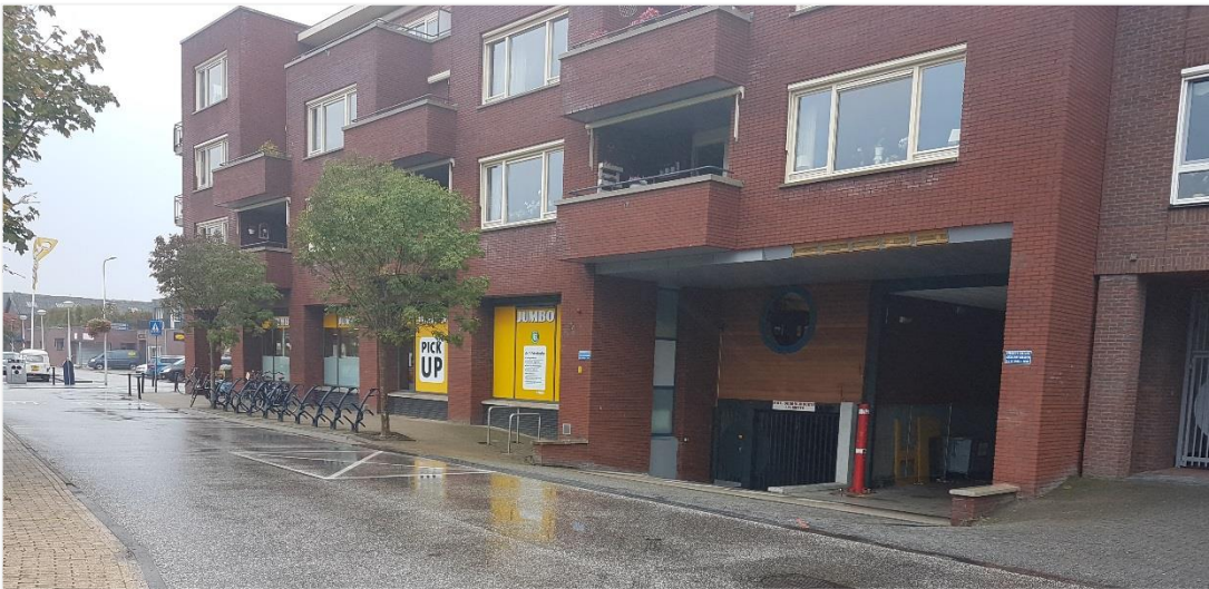
Figuur 4-3 Als water afstroomt naar het laagste punt, dan zijn lage plekken als kelders en verlaagde laadplatformen kwetsbaar (foto: centrum Woudenberg).
