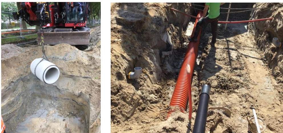
Figuur 7-3 Rioolvervanging Woudenberg
