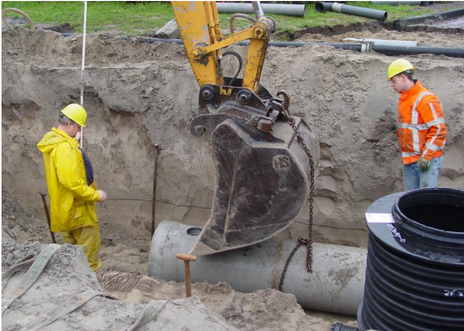
Afbeelding 6.4. Archeologische begeleiding van aanleg riool. Kruissloot, Sint Pancras, Langedijk (bron: Provinciaal Depot voor Archeologie Noord-Holland, foto RAAP Archeologisch Adviesbureau).
