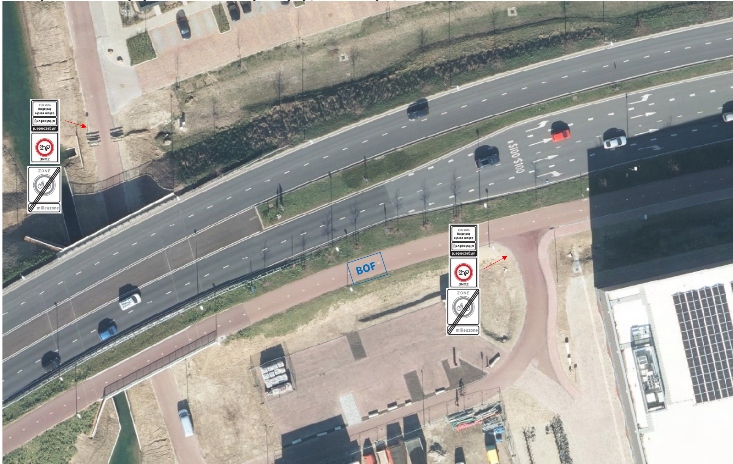
Michelangelostraat onderdoorgang Generaal James Gavingsingel + toegangspad Jozef Rodriguezplein
