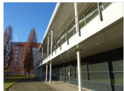
Figuur 2.5 Oostelijk aanzicht van het hoofdgebouw.
