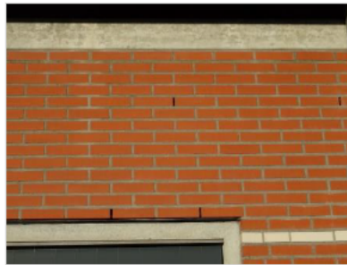
Figuur 4.7 Stootvoegen in fietsenstalling.
