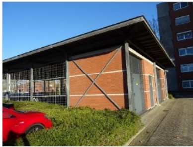
Figuur 4.6 Fietsenstalling met geschikte openingen voor vleermuizen.
