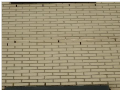
Figuur 4.3 Open stootvoegen.
