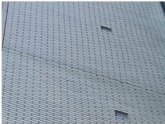
Figuur 2.7 Detail zuidelijke kopgevel met een horizontale strook met open stootvoegen en een verticale dilatatievoeg (links).
