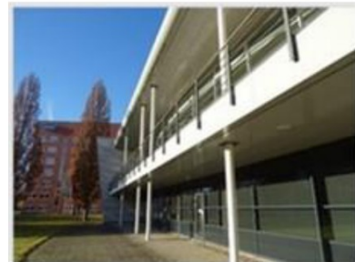
Figuur 2.5 Oostelijk aanzicht van het hoofdgebouw.
