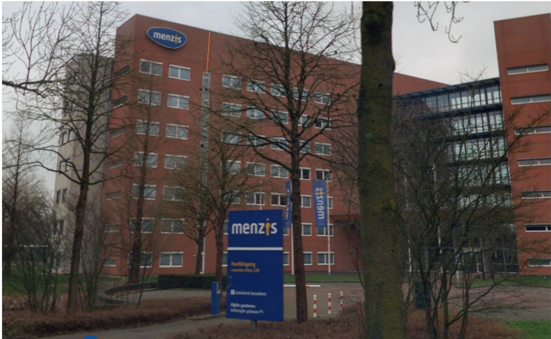
Figuur 4. Het verticale raam aan de oostgevel met daarboven een spouwborstel (oranje). De spouw loopt door de hoek om. Hierdoor zijn de rode zuidgevel en de rode oostgevel met elkaar verbonden. De spouwborstel en het verticale raam vormen tijdens de werkzaamheden een fysieke scheiding tussen het massawinterverblijf en het kraamverblijf. Rechts van de spouwborstel is het zuidelijke deel van de oostgevel en links van de spouwborstel is het noordelijke deel van de oostgevel
