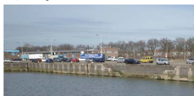
Aanvullend: Bestaande kades
