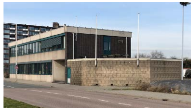
12. Marconistraat 105, Douanekantoor Rijksgebouwendienst, 1968-1970 Typologie: Kantoorgebouw
