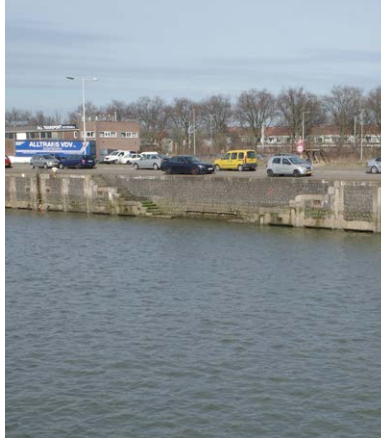
Aanvullend: Bestaande kades
