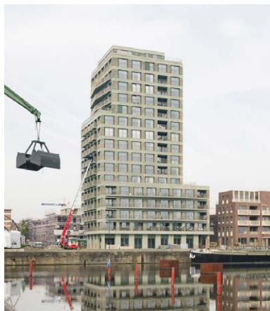
Monolitisch gebouw met samenhangende architectuur
