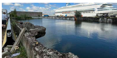
Aanvullend: Kelderbak van het voormalige koelhuis (tussen nr. 4 en 6)
