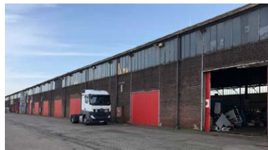
5. Radiostraat 27, Loodsen Blaauwhoedenveem-Vriesseveem NV Hollandse Constructie Werkplaatsen 1947
