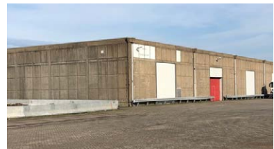
6. Radiostraat 1, Loods Nederland, Presto Stuwadoors Maatschappij H.A. Dicke 1948-1949
