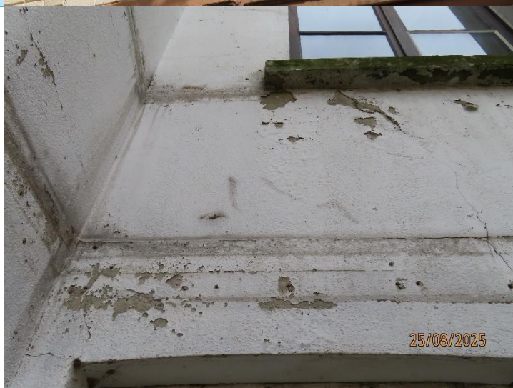
Gevels en kozijnen (Schilderwerk achtergevel)
