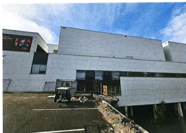
Figuur 5: Zijgevel naastgelegen bebouwing
