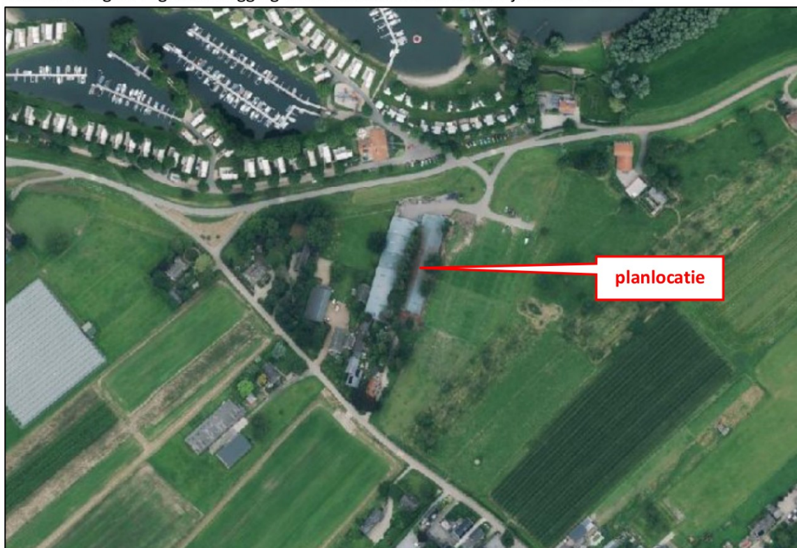
Figuur 1. Luchtfoto met ligging bedrijfslocatie
