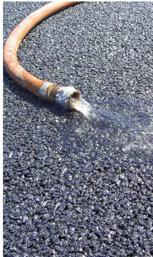
Waterdoorlatend asfalt
