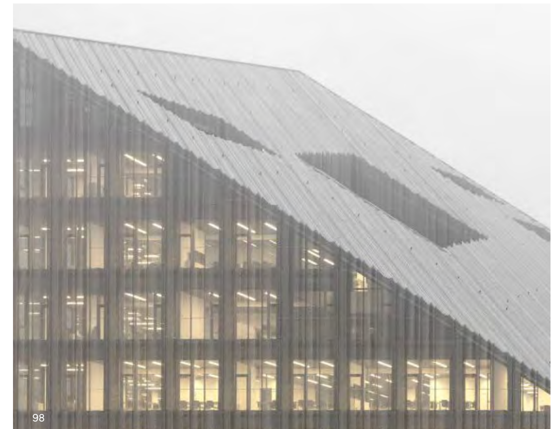
Hellend dak volgt het gehele dakoppervlakte en dezelfde materialisatie als de gevel.
