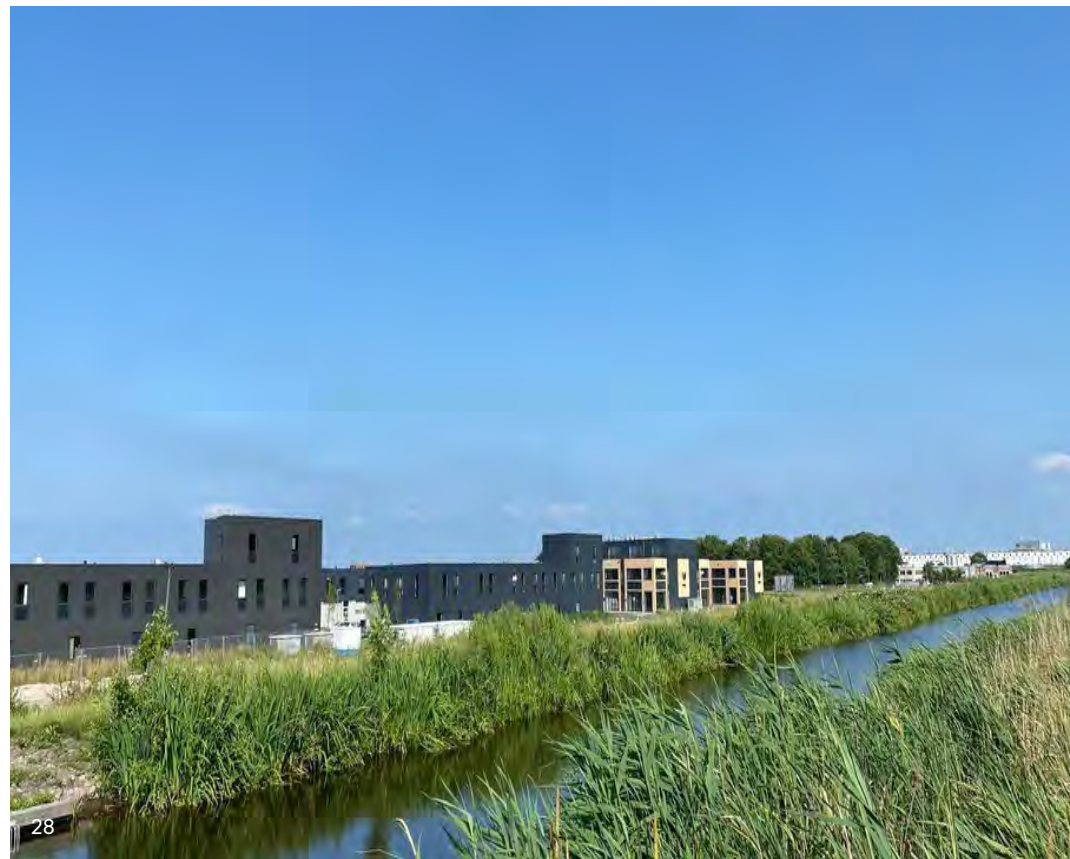
Watersysteem wordt niet onderbroken
