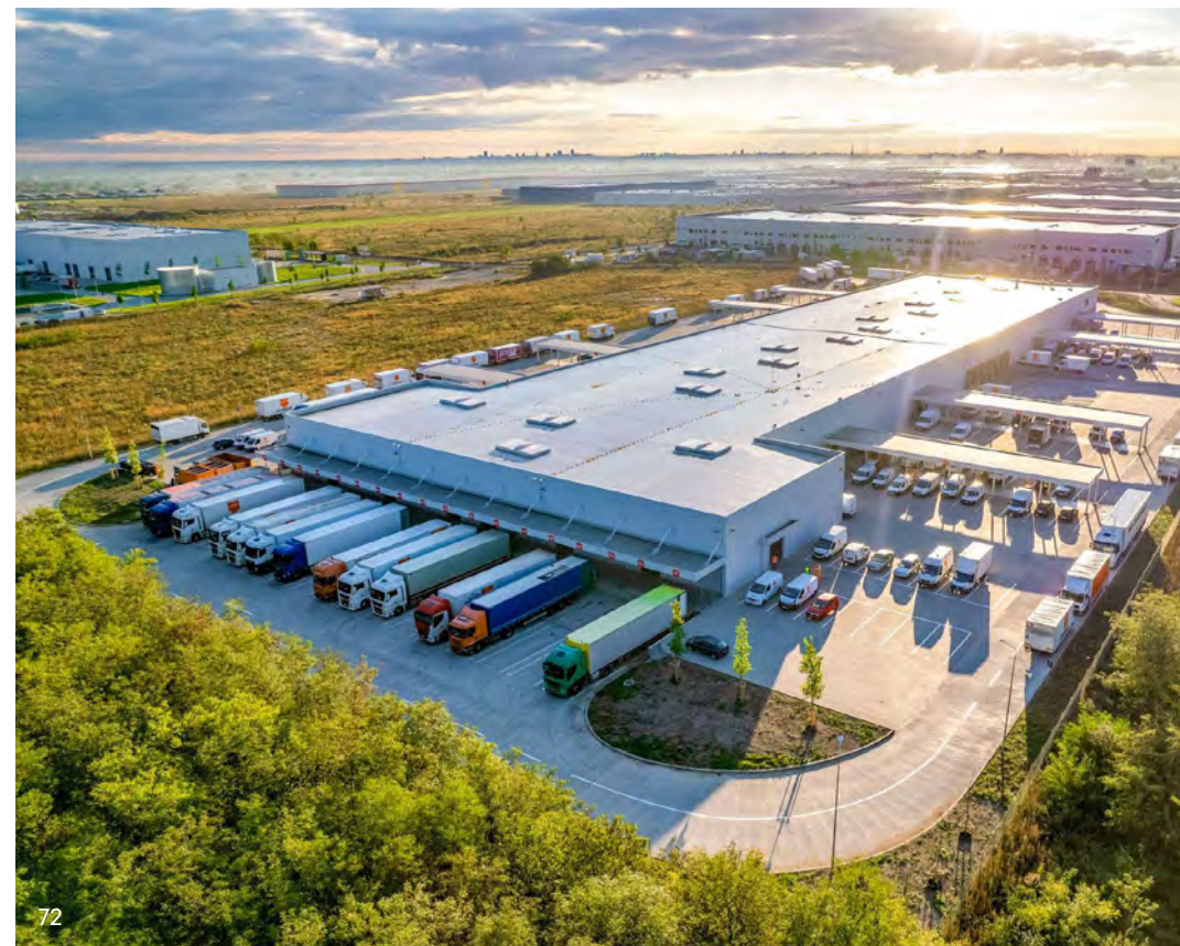
Laadperrons geclusterd geplaatst
