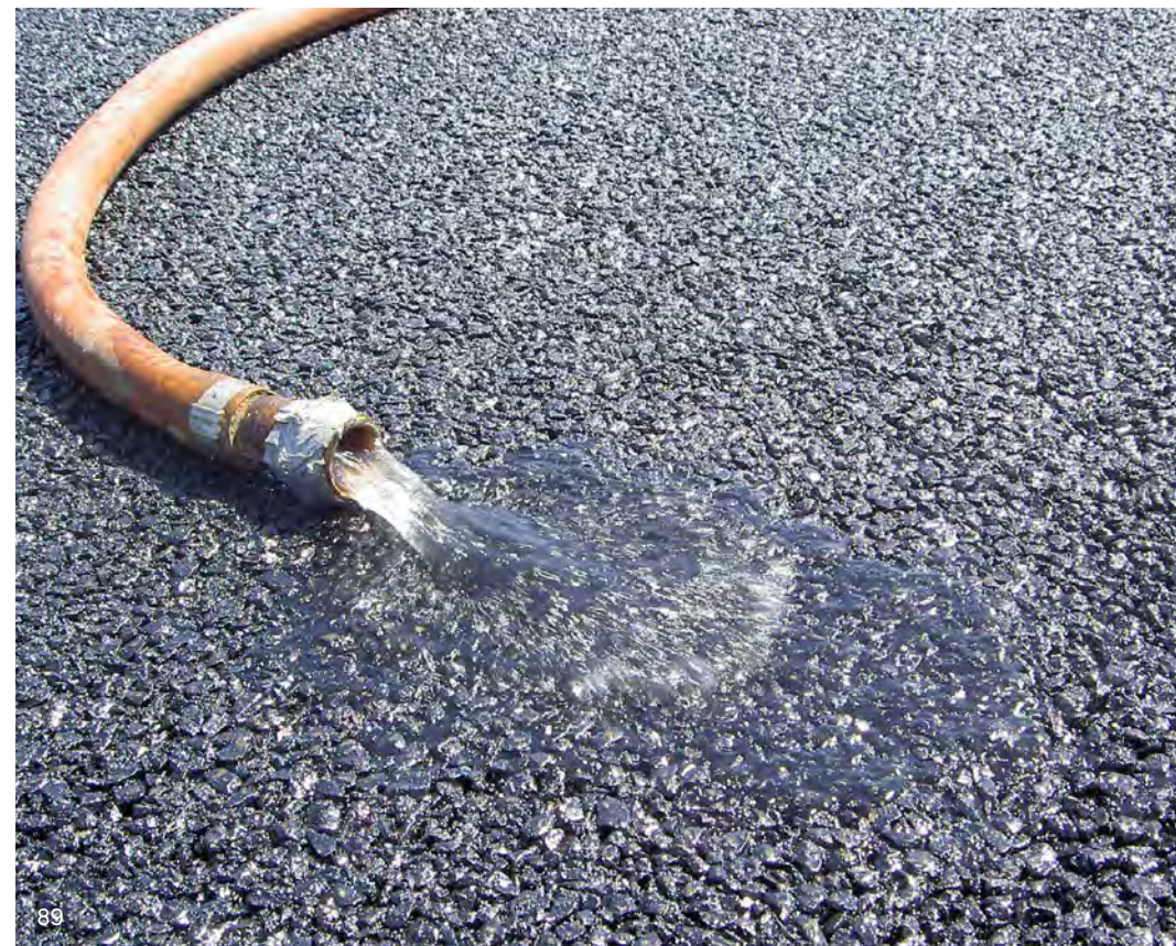
Waterdoorlatend asfalt
