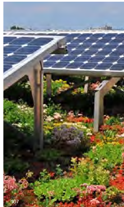
Energie en groen op dak
