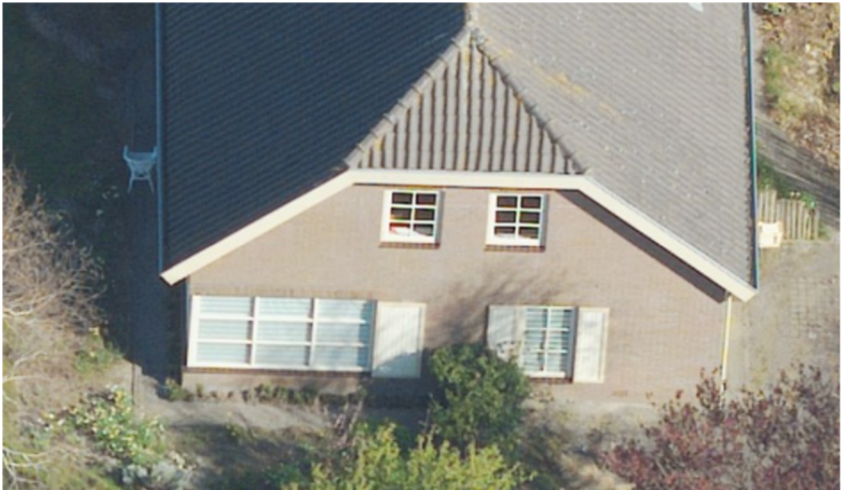
Gevelbeoordeling(bovenstaand): geen bijzonderheden -> gevelgeluidwering van \geq 16 dB.
