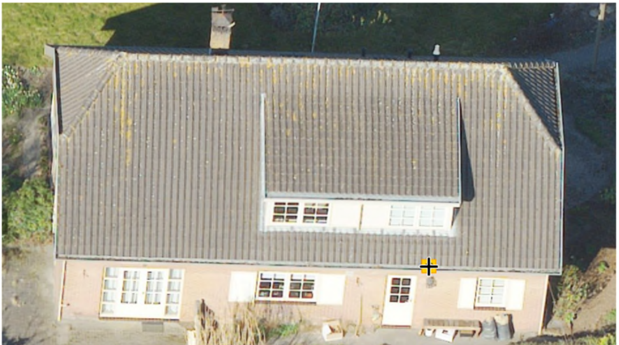
Gevelbeoordeling(bovenstaand): lichte opbouw van de dakkapel. De wangen van de dakkapel zijn voorzien van rabat. Ook de voorzijde waarin het kozijn zit. Deze dakkapel zit echter aan de 'luwe' zijde en is dus hier niet relevant (berekende geluidbelasting bedraagt hier 32 dB(A)).
