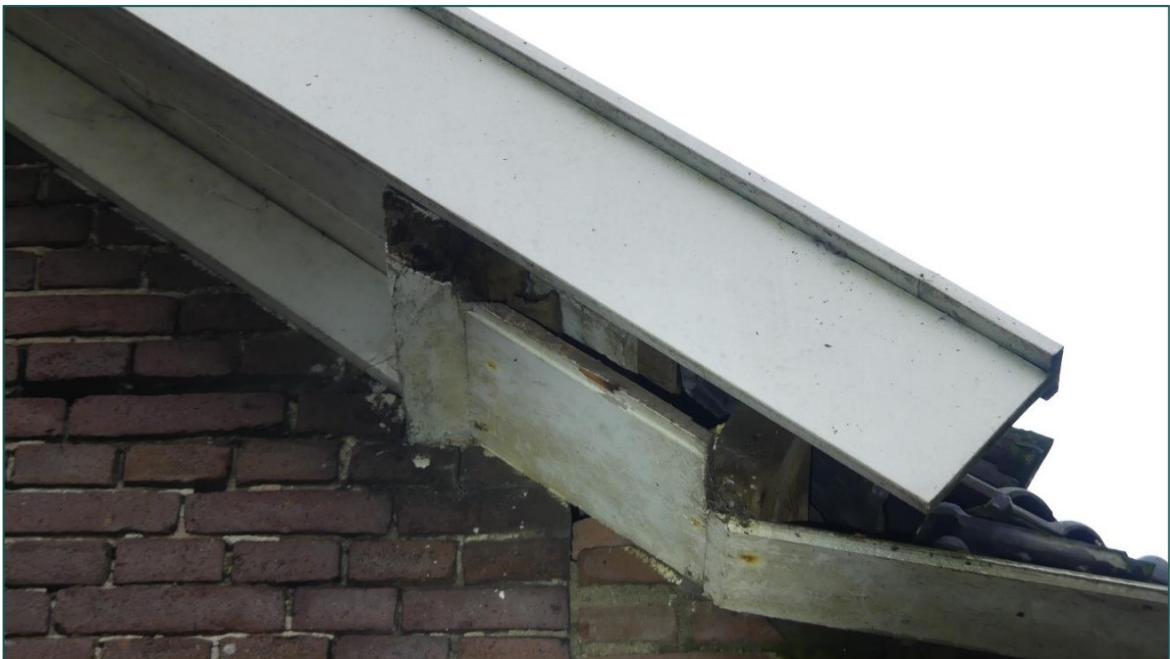
Figuur 3.3 Huismussen kunnen de bebouwing gebruiken als nestlocatie via gaten in het dak.
