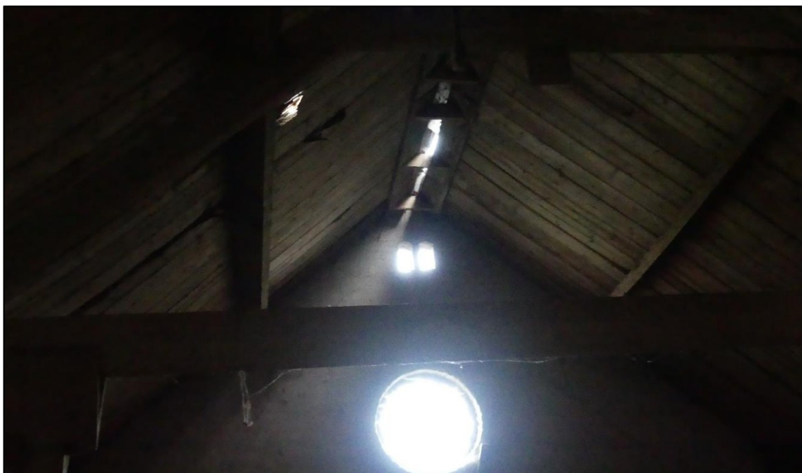
Figuur 3.2 De zolder is voor vleermuizen toegankelijk via kieren in het dak en biedt mogelijkheid tot verblijfplaatsen en/of foerageergebied voor bijvoorbeeld gewone grootoorvleermuis.
