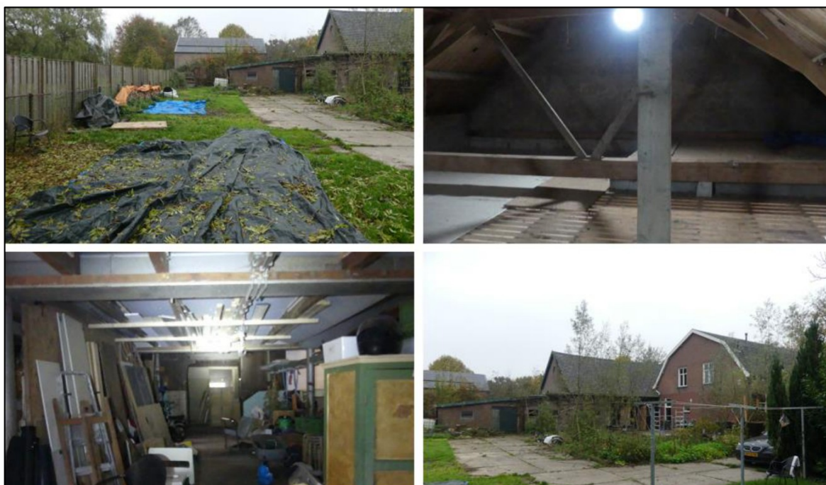
Figuur 3.1 De planlocatie beschikt over een onderhouden tuin. De schuur wordt tevens gebruikt voor de opslag van materialen en er zijn verder geen sporen als prooiresten of latrines aangetroffen welke indicierend zijn voor de aanwezigheid van marterachtigen.
