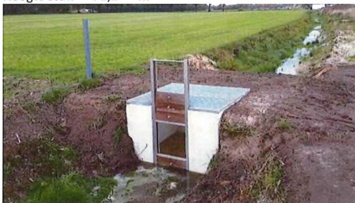
2. Voorbeeldfoto van een schotbalkstuw die geplaatst gaat worden.
