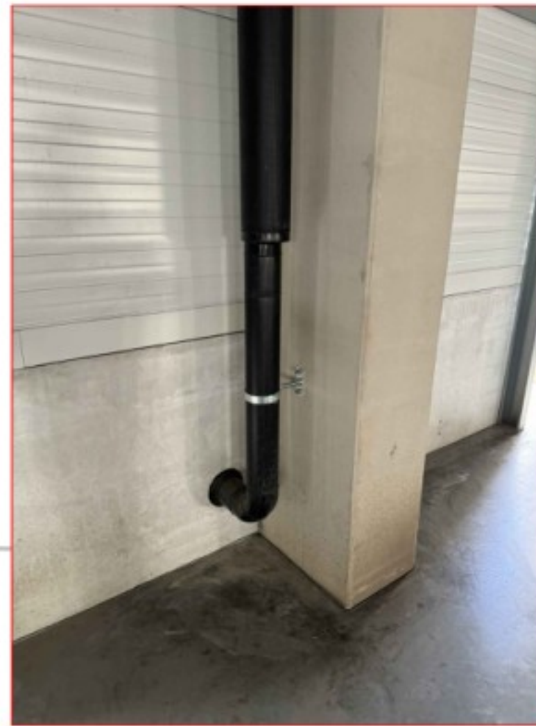
Voorbeeld noodoverstort doorvoer
