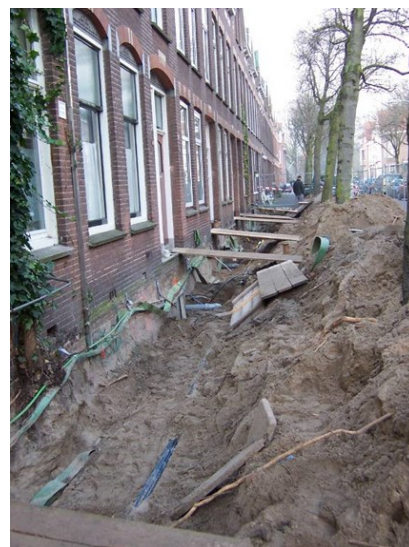
Figuur 6: Werk aan kabels en leidingen.
