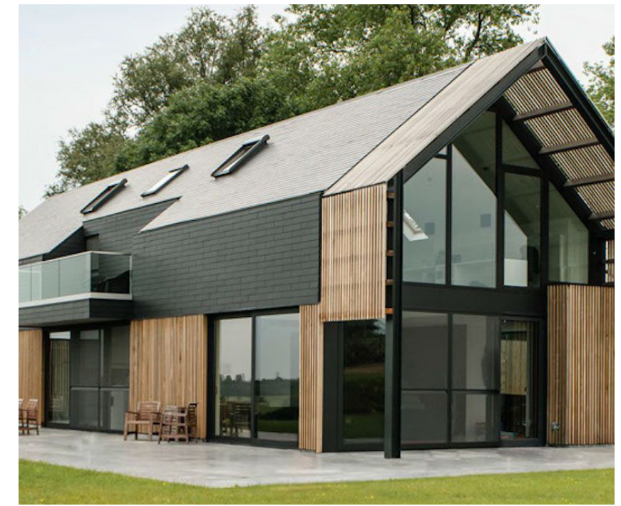
Schuurwoning met een opbouw in 1,5 bouwlagen en een kap
