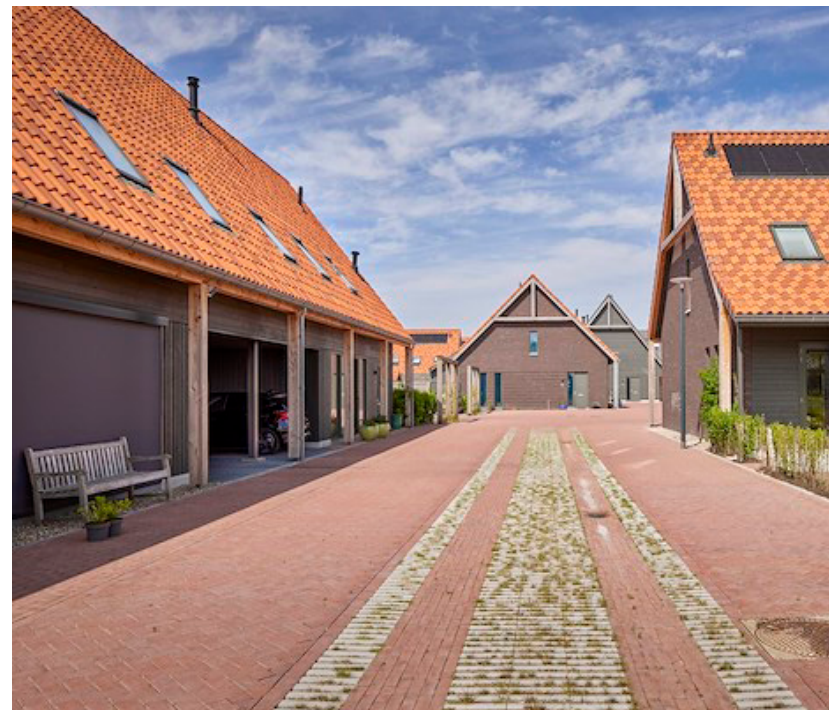
Boerenerf met schuurwoningen (eenvoudige kapvormen)
