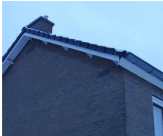
Figuur 8.7 Voorbeeld inbouwkast type IB GZ 03 ingebouwd een kopgevel.
