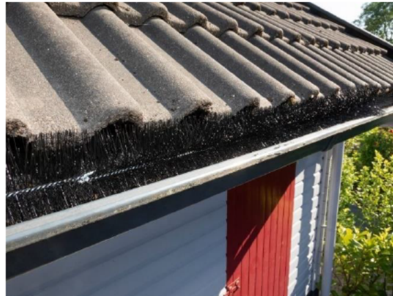
Figuur 8.4 Voorbeeld van toepassen spouwborstels in dakgoot.
