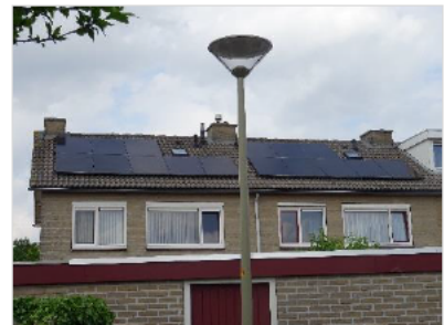
Figuur 2.5 Achterkant van de woningen
