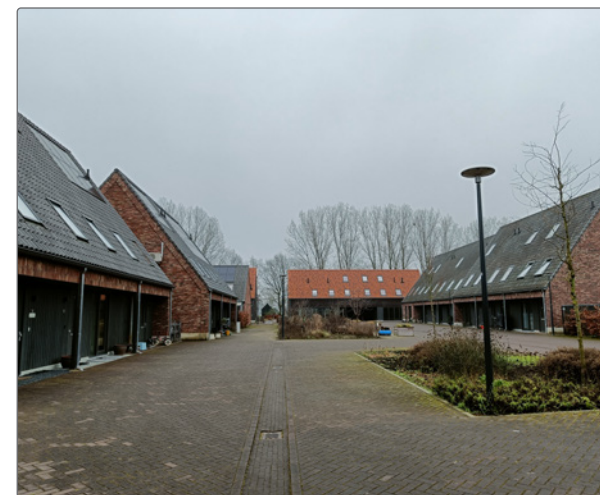
Nieuwbouw Veghels Buiten al deels opgeleverd
