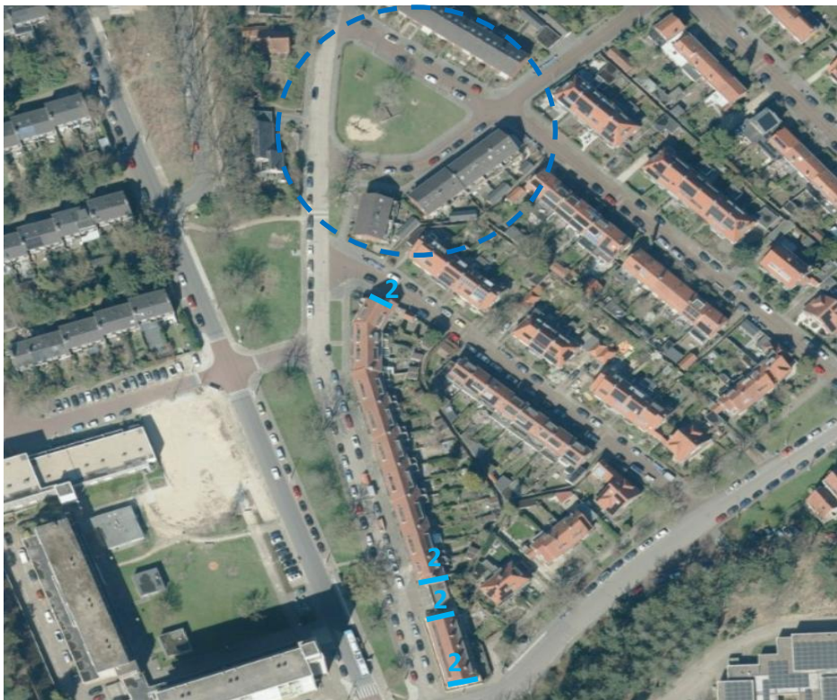
Afbeelding 9: Locaties en aantallen van de tijdelijke vleermuiskasten aangegeven met de blauwe vlakken, lijnen en getallen. De blauwe stippellijn geeft het zuidelijke deel van de planlocatie weer. De verblijven zijn niet op schaal getekend. De roze vlakken geven huismuiskasten weer.
