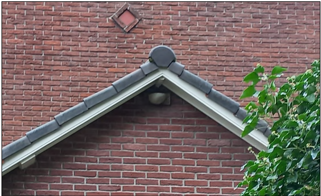
Foto 8. Een nestkom voor huiszwaluw onder het dak van een schuurtje van een woning aan de Händelstraat.
