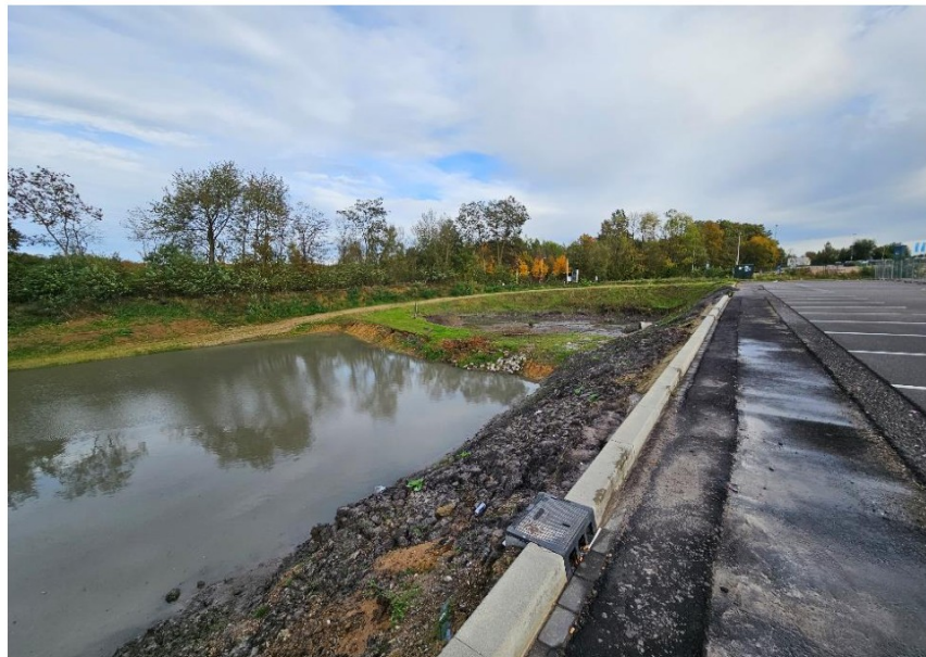
Figuur 5: Plangebied gezien vanuit het zuidwesten
