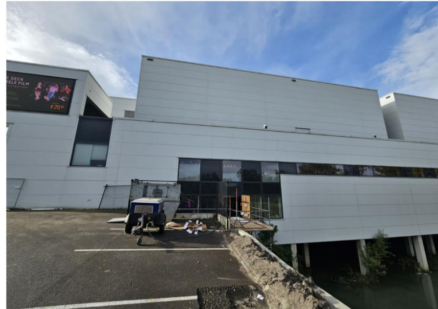
Figuur 5: Zijgevel naastgelegen bebouwing
