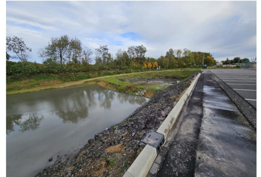
Figuur 6: Plangebied gezien vanuit het zuidwesten
