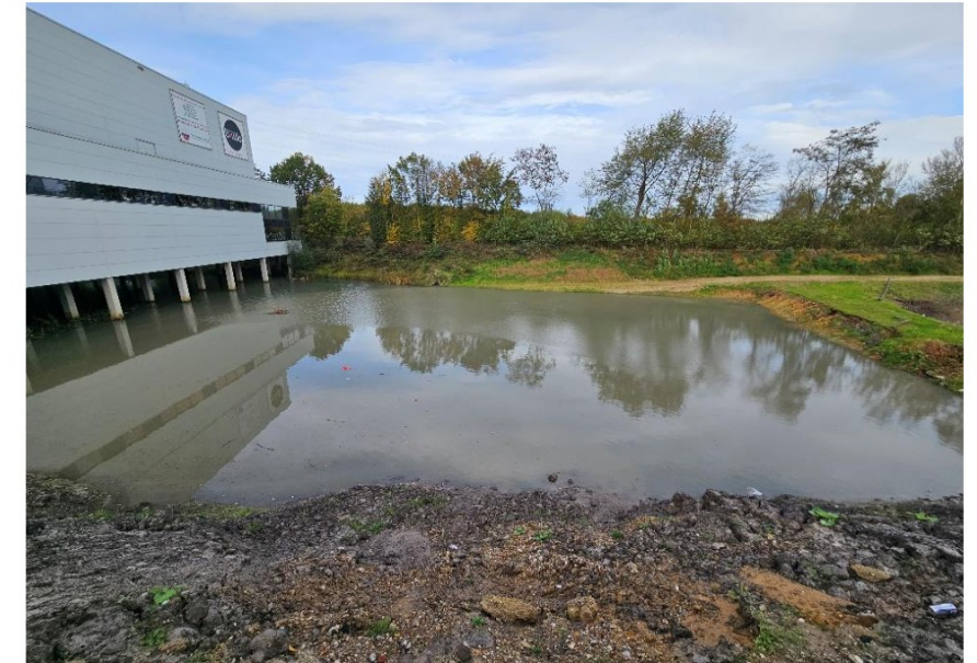
Figuur 4: Plangebied gezien vanuit het zuiden, met naastgelegen het [redacted]
