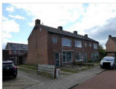
Figuur 2.3 Bebouwing aan de Rozenstraat (17-21).
