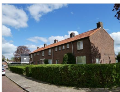
Figuur 2.11 Bebouwing aan de Enkweg (13-19).
