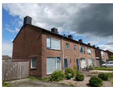
Figuur 2.29 Bebouwing aan de Wethouder Sandersstraat (64-72).
