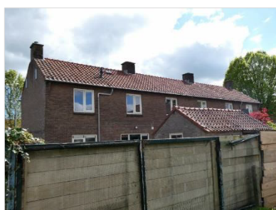
Figuur 2.10 Bebouwing aan de Enkweg (26-30).
