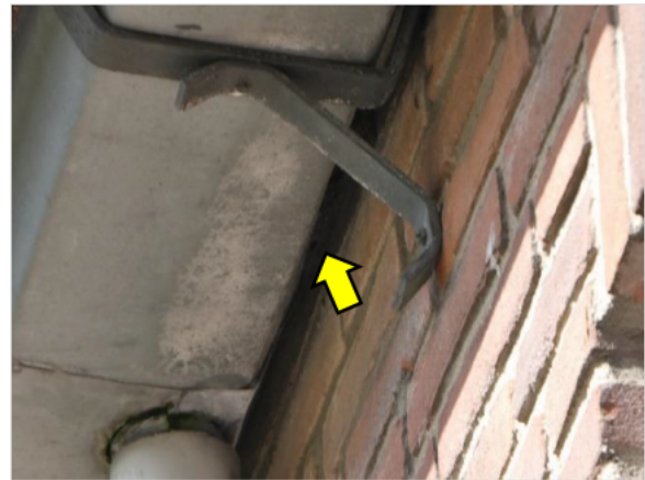
Figuur 4.6 Opening onder de dakgoot.
