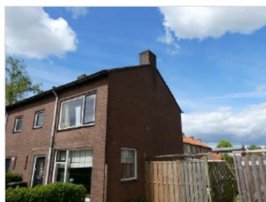
Figuur 2.30 Bebouwing aan de Wethouder Sandersstraat (64-72).
