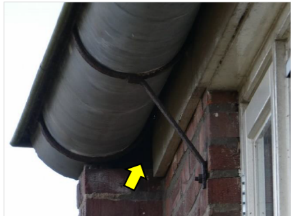
Figuur 4.2 Ruimte onder de dakgoot.
