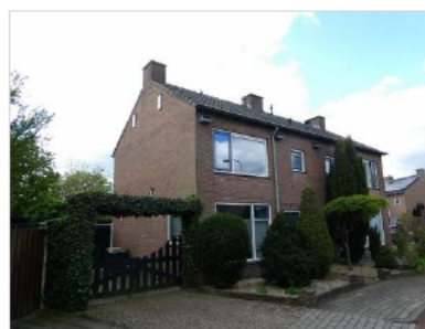
Figuur 2.5 Bebouwing aan de Rozenstraat (23 en 25).
