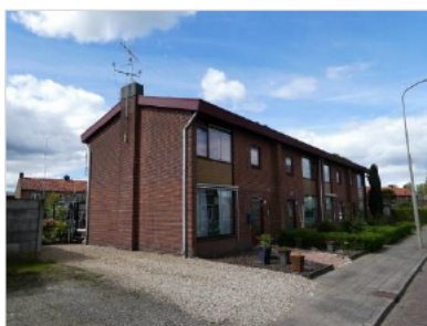
Figuur 2.31 Bebouwing aan de Enkweg (34-40).
