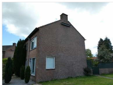
Figuur 2.6 Bebouwing aan de Rozenstraat (23 en 25).
