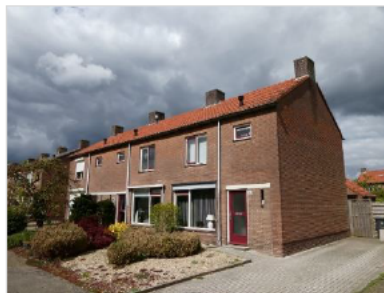
Figuur 2.17 Bebouwing aan de Wethouder Sandersstraat (40-50).
