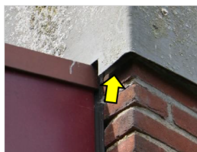
Figuur 4.19 Ruimte bij schoorsteenkap.
