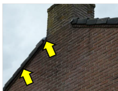
Figuur 4.16 Ruimte bij kantpannen en loodslabben.
