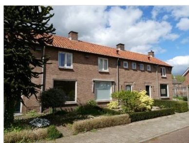
Figuur 2.9 Bebouwing aan de Enkweg (26-30).
