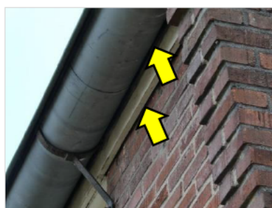
Figuur 4.17 Ruimte achter dakgoot en achter betimmering.
