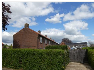
Figuur 2.12 Bebouwing aan de Enkweg (13-19).
