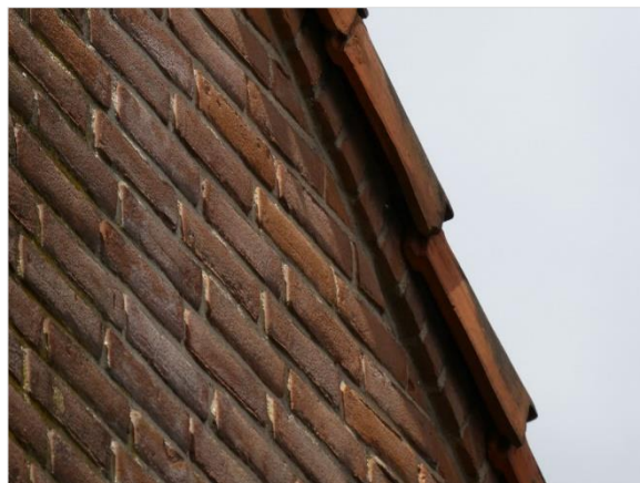
Figuur 5.6 Nestlocatie van gierzwaluw bij ruimte onder overhangende kantpannen.
