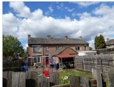
Figuur 2.4 Bebouwing aan de Rozenstraat (17-21).
