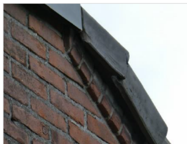
Figuur 3.10 Verblijfplaats van vleermuis bij overhangende kantpannen.
