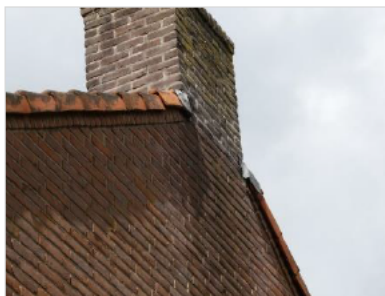
Figuur 3.9 Verblijfplaats van vleermuis bij overhangende kantpannen en loodslabben.
