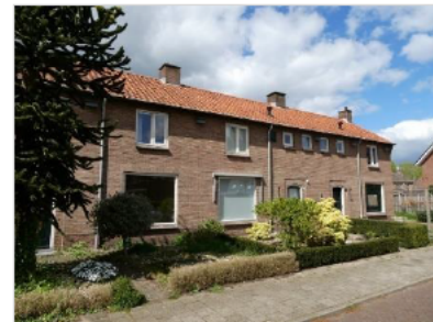
Figuur 2.5 Bebouwing aan de Enkweg (26-30).
