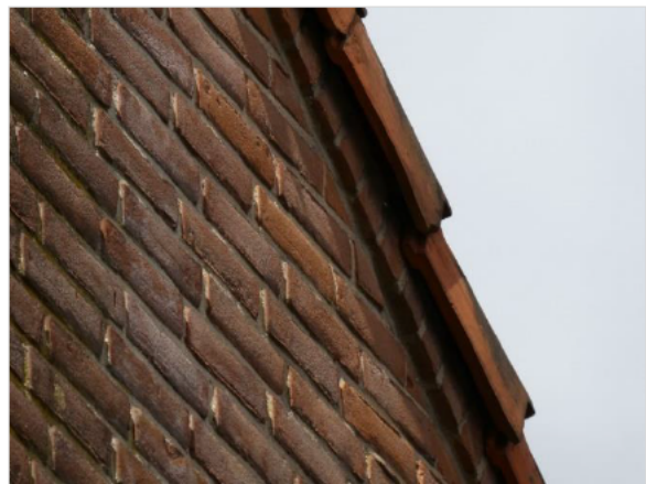
Figuur 3.6 Nestlocatie van gierzwaluw bij ruimte onder overhangende kantpannen.
