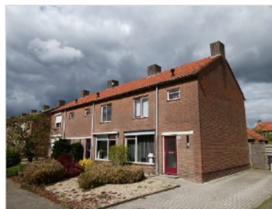
Figuur 2.7 Bebouwing aan de Wethouder Sandersstraat (40-50).
