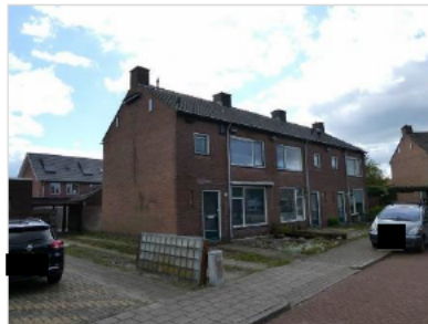
Figuur 2.3 Bebouwing aan de Rozenstraat (17-21).
