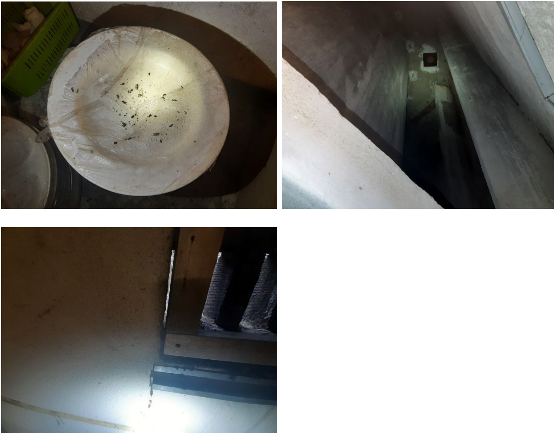
Afbeelding 5.1: waarnemingen in het pand: mogelijke uitwerpselen van vleermuizen, verschillende plekken om te verblijven voor vleermuizen en openingen geschikt voor vleermuizen om in te kruipen.
