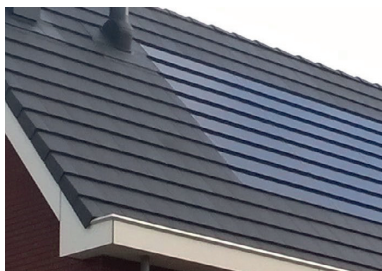
panelen verwerkt in het dak
