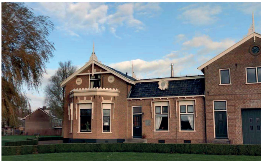
Beeld van de voormalige zuivelfabriek
