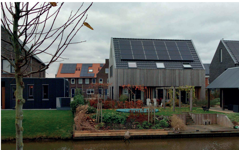
Voorbeeld van een oever met een steiger aan het water
