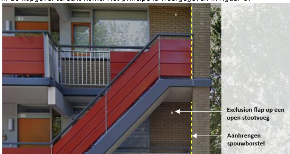
Figuur 8: Principeoplossing ongeschikt maken langsgevel (Laneco, 2025).
