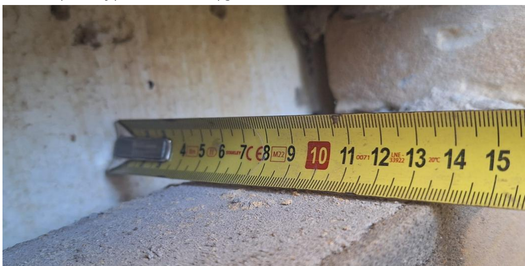
Figuur 3: Foto van de spouwmuur langsgevels tegen de kopgevels aan (foto: Laneco, 2025).
