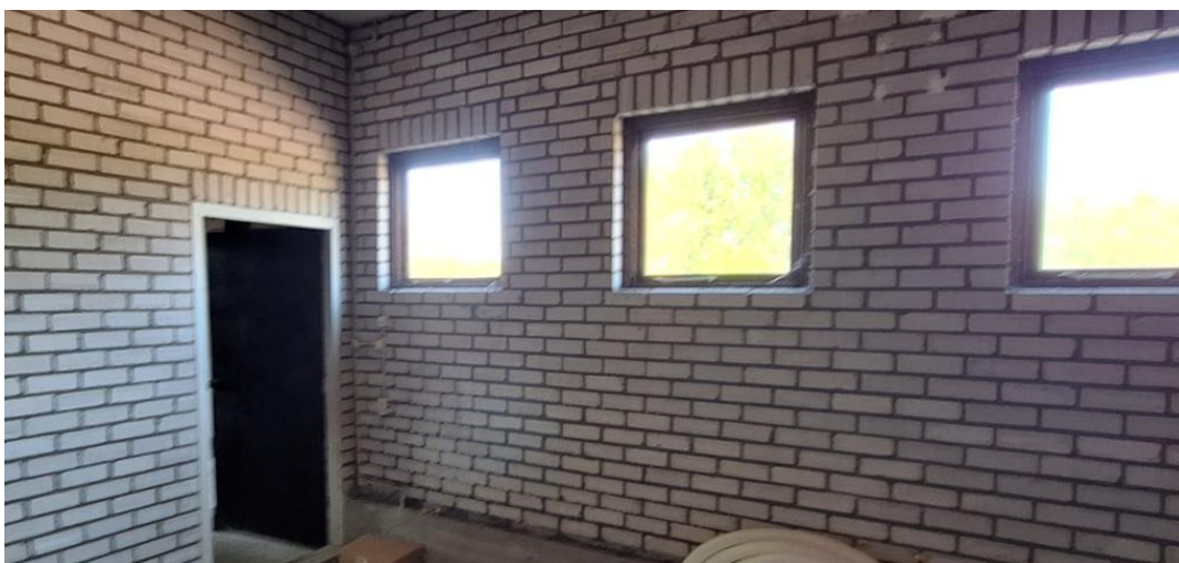
Figuur 4: Foto's oude CV ruimtes met noordgevel binnenuit (boven) en zuidgevel van binnenuit (onder) (foto's: Laneco, 2025)
