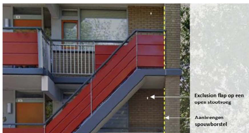
Figuur 4: Principeoplossing ongeschikt maken lengtegevel (Laneco, 2025).
