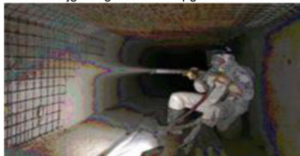
Figuur 2. Reparatie met schuimbeton
