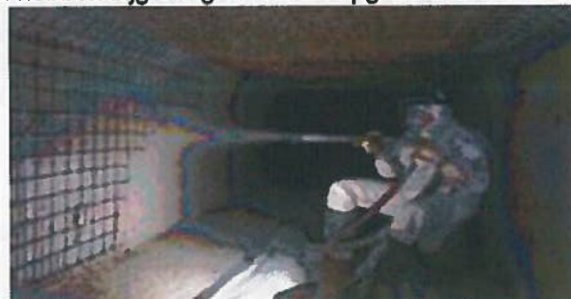
Figuur 2. Reparatie met schuimbeton
