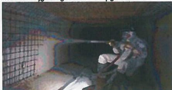
Figuur 2. Reparatie met schuimbeton
