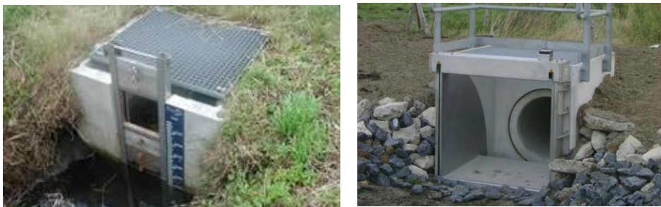
Afbeelding 4.1: Voorbeelden van nieuw aan te brengen regelwerken (bron: BTL)
