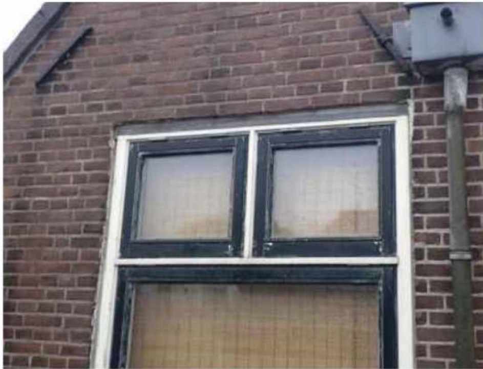
Draairamen verdieping achtergevel
