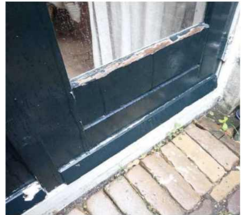
Deurstel begane grond achtergevel
